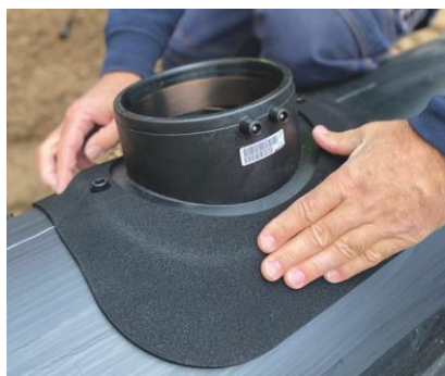
Samolepicí gumová podložka utěšňuje sedlo na potrubí ASA VL d160.
